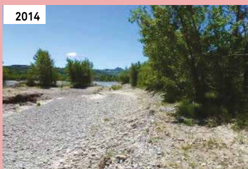
Figura 25 - Riapertura di un alveo secondario interrato lungo il Fiume Taro realizzato nel Comune di Medesano all'interno del Parco fluviale del fiume Taro (Macroarea dell'Emilia Occidentale). L'intervento, realizzato mediante scavo del canale abbandonato e reimmissione dei sedimenti in alveo, ha avuto lo scopo di ripristinare un canale secondario parzialmente interrato (si vedano le foto relative agli anni 2000, 2008 e 2010) al fine di contrastare il processo di banalizzazione ecologica e di abbassamento del fondo che ha subito l'aveo del fiume negli ultimi decenni a causa delle massicce
