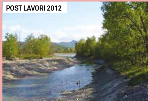
Figura 25 - Riapertura di un alveo secondario interrato lungo il Fiume Taro realizzato nel Comune di Medesano all'interno del Parco fluviale del fiume Taro (Macroarea dell'Emilia Occidentale). L'intervento, realizzato mediante scavo del canale abbandonato e reimmissione dei sedimenti in alveo, ha avuto lo scopo di ripristinare un canale secondario parzialmente interrato (si vedano le foto relative agli anni 2000, 2008 e 2010) al fine di contrastare il processo di banalizzazione ecologica e di abbassamento del fondo che ha subito l'aveo del fiume negli ultimi decenni a causa delle massicce
