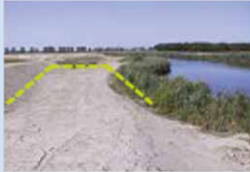
Figura 6 – Esempio di arretramento arginale sul fiume Zero (Provincia di Venezia).
