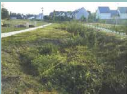
Figura 50 – Esempio di incremento della sinuosità del tracciato lungo il rio Mardereau presso Sorigny (Bacino della Loira – Francia). Si tratta di un tipico intervento per il recupero della sinuosità su un corso d'acqua appartenente al reticolo minore che risultava estremamente banalizzato a seguito di interventi di rettificazione. Il recupero della sinuosità è stato conseguito allargando la sezione, tracciando un alveo meandriforme, inserendo sedimenti grossolani in alcuni punti per favorire la diversificazione del substrato ed infine mettendo a dimora vegetazione acquatica ed arborea per accelerare il recupero della componente vegetale. Intervento e foto: Syndicat intercommunal d'aménagement de la vallée de l'Indre (SAVI).
