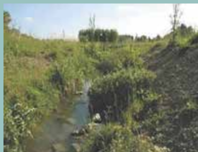
Figura 50 – Esempio di incremento della sinuosità del tracciato lungo il rio Mardereau presso Sorigny (Bacino della Loira – Francia). Si tratta di un tipico intervento per il recupero della sinuosità su un corso d'acqua appartenente al reticolo minore che risultava estremamente banalizzato a seguito di interventi di rettificazione. Il recupero della sinuosità è stato conseguito allargando la sezione, tracciando un alveo meandriforme, inserendo sedimenti grossolani in alcuni punti per favorire la diversificazione del substrato ed infine mettendo a dimora vegetazione acquatica ed arborea per accelerare il recupero della componente vegetale. Intervento e foto: Syndicat intercommunal d'aménagement de la vallée de l'Indre (SAVI).
