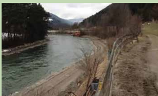
Figura 43 - Reintroduzione di sedimenti a valle di uno sbarramento idroelettrico sul fiume Rienza (Provincia Autonoma di Bolzano – Ripartizione Opere Idrauliche).
