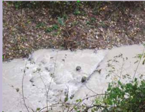
Figura 19 – Esempio di posizionamento in alveo di strutture in legno per l'aumento della scabrezza e la diversificazione degli habitat (rio Lavezza, Comune di Albinea in Provincia di Reggio Emilia). L'intervento è stato realizzato nell'ambito del Progetto Europeo LIFE+ RII ( http://ambiente.regione.emilia-romagna.it/life-rii/temi/progetto-life-rii/life-rii ) di cui la Regione Emilia-Romagna è ente capofila. Nelle prime due foto in alto è mostrato a sinistra l'ancoraggio alla sponda di due tronchi dotati di radice esposta e a destra l'intervento attraversato da una morbida del rio. Nelle due foto in basso è mostrato a sinistra un tronco posto trasversalmente all'alveo ancorato alle sponde e a destra l'intervento attraversato da una morbida del rio Lavezza. Intervento realizzato dal Consorzio di Bonifica dell'Emilia Centrale (RE). Foto: Marco Monaci, Aronne Ruffini.
