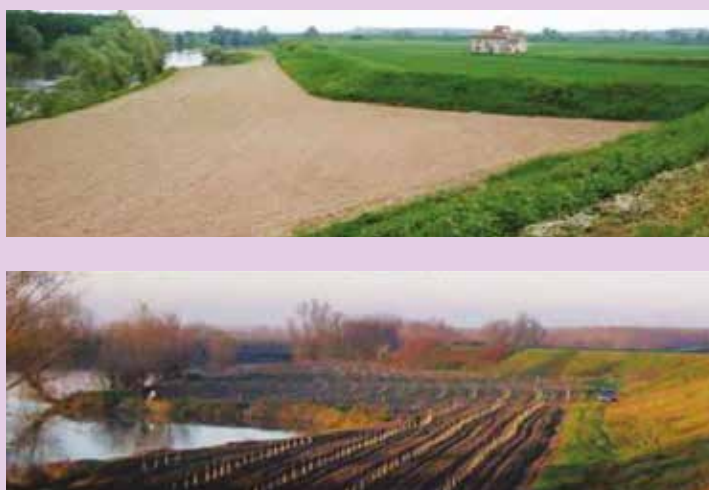
Figura 17 – L'immagine mostra un intervento di forestazione in una golena del fiume Oglio, con effetti che possono essere sia naturalistici sia di tipo idraulico, grazie al rallentamento della corrente esercitato dagli alberi. Sebbene non realizzato per fini idraulici, l'intervento rappresenta una possibile applicazione dell'azione descritta. Intervento realizzato dal Parco fluviale Oglio Sud (Regione Lombardia). Foto: Bruno Boz.
