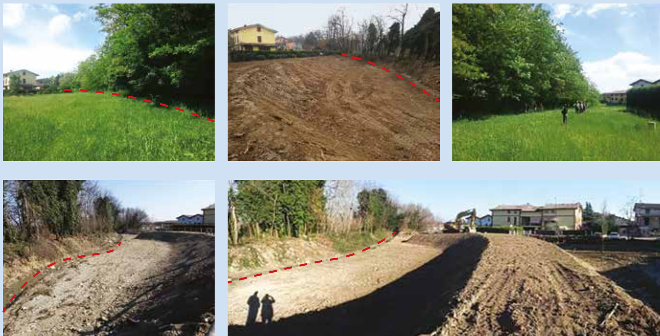
Figura 7 - Esempio di arretramento arginale lungo il rio Enzola (Provincia di Reggio Emilia). L'intervento fa parte di un complesso di azioni sviluppate nell'ambito del Progetto Europeo LIFE+ RII (il cui ente capofila è la Regione Emilia-Romagna) volte a diminuire la situazione di pericolosità idraulica generata dal rio Enzola in relazione ai Comuni di Quattro Castella e Bibbiano (RE). Il rio Enzola nasce nell'area collinare posta a monte del primo comune e, dopo un breve tratto di qualche chilometro ad elevata pendenza, si immette nell'alta pianura per poi attraversare, tombinato per circa 2 km, Quattro Castella stessa. In corrispondenza di tale attraversamento si creano problemi di tipo idraulico, a causa della sezione insufficiente dello scatolare presente, problemi che poi si ripresentano nel successivo tratto a cielo aperto, che va da Quattro Castella sino a Bibbiano, dove il corso si presenta come arginato pensile e con sezione insufficiente. Gli interventi eseguiti ( http://ambiente.regione.emilia-romagna.it/life-rii/temi/progetto-life-rii/life-rii ) affrontano il problema idraulico ricercando un contemporaneo miglioramento della qualità ecologica del rio (o la sua conservazione ove non possibile altrimenti), in particolare creando piana inondabile o comunque aumentando le aree di ritenzione delle piene, in modo distribuito lungo il tratto d'asta non arginato. L'intervento mostrato nelle foto rientra in tale categoria e prevede di ampliare l'area di accumulo delle piene mediante l'arretramento dell'argine presente in destra idraulica all'interno del Comune di Quattro Castella (linea rossa tratteggiata) e lo sbancamento dell'area retrostante. Le immagini mostrano l'intervento appena realizzato prima del ripristino della fascia riparia, confrontando la situazione ante e post operam, in una vista da valle verso monte (sopra) e da monte verso valle (sotto). Nel caso specifico l'intervento non ricrea piana inondabile ma crea ex novo tale piana in modo diffuso lungo il rio, per contrastare la problematica idraulica sopra indicata. Intervento realizzato dal Consorzio di Bonifica dell'Emilia Centrale (RE). Foto: Marco Monaci, Aronne Ruffini.
