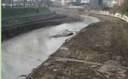
Figura 42 – Esempio di reimmissione di sedimenti lungo il fiume Montone (Forlì).
