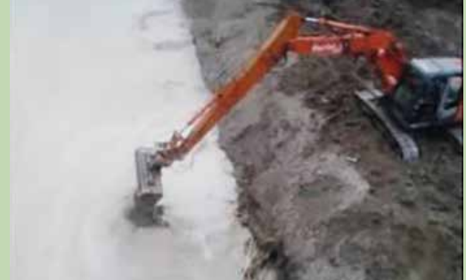
Figura 42 – Esempio di reimmissione di sedimenti lungo il fiume Montone (Forlì).
