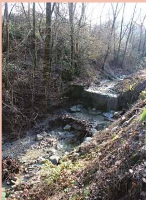
Figura 34 - Esempio di modifica di una briglia lungo il rio Enzola nel Comune di Quattro Castella (RE). L'intervento ha previsto la modifica strutturale di una briglia mediante sostituzione con una rampa in massi atta a ripristinare la continuità ecologica del rio. L'intervento fa parte di un complesso di azioni sviluppate nell'ambito del Progetto europeo LIFE+ RII (il cui Ente capofila è la Regione Emilia-Romagna) volte a diminuire la situazione di pericolosità idraulica e a migliorare la qualità ecologica dei rii oggetto di intervento ( http://ambiente.regione.emilia-romagna.it/life-rii/temi/progetto-life-rii/life-rii ). Intervento realizzato dal Consorzio di bonifica dell'Emilia Centrale (RE). Foto Marco Monaci, Aronne Ruffini.
