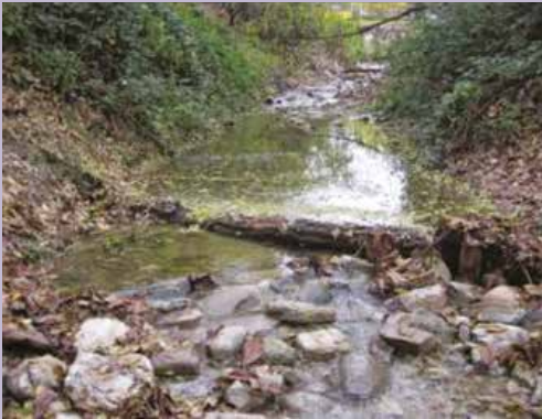
Figura 19 – Esempio di posizionamento in alveo di strutture in legno per l'aumento della scabrezza e la diversificazione degli habitat (rio Lavezza, Comune di Albinea in Provincia di Reggio Emilia). L'intervento è stato realizzato nell'ambito del Progetto Europeo LIFE+ RII ( http://ambiente.regione.emilia-romagna.it/life-rii/temi/progetto-life-rii/life-rii ) di cui la Regione Emilia-Romagna è ente capofila. Nelle prime due foto in alto è mostrato a sinistra l'ancoraggio alla sponda di due tronchi dotati di radice esposta e a destra l'intervento attraversato da una morbida del rio. Nelle due foto in basso è mostrato a sinistra un tronco posto trasversalmente all'alveo ancorato alle sponde e a destra l'intervento attraversato da una morbida del rio Lavezza. Intervento realizzato dal Consorzio di Bonifica dell'Emilia Centrale (RE). Foto: Marco Monaci, Aronne Ruffini.
