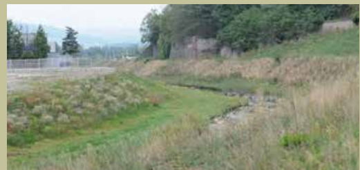
Figura 47 – Esempio di riapertura e riqualificazione di un tratto del fiume Ondaine, affluente della Loira, nelle vicinanze della città di Saint Etienne (Francia). Nel tratto in cui attraversa l'abitato di Chambon-Feuergrolles, in una ex zona industriale, il corso d'acqua era stato tombato. Nel 1998 ci furono le prime avvisaglie di cedimento della volta: a seguito di ciò, nell'ambito del locale contratto di fiume e contestualmente a un progetto di riqualificazione urbana, nel 2003 fu ipotizzato di rimuovere la copertura del corso d'acqua. Negli anni seguenti vennero scoperte a più riprese fonti di inquinamento all'interno del sito e fu necessario procedere ad una fase di bonifica. I lavori veri e propri sono stati realizzati nel 2009, dopo aver constatato l'ulteriore degrado della volta a causa di eventi alluvionali. L'eliminazione del tombamento ha
